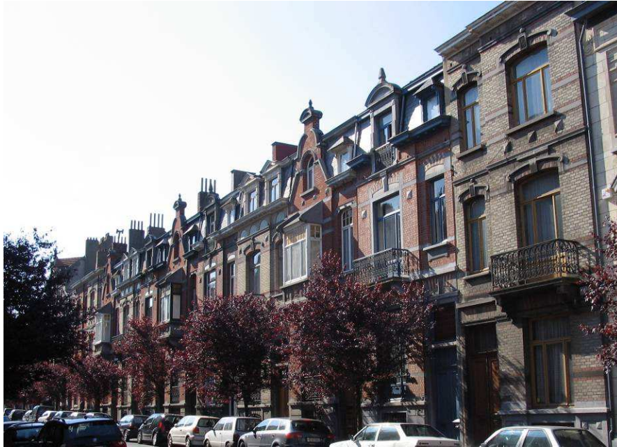
Rue de la Réforme 5 à 27 (photo 2005).
