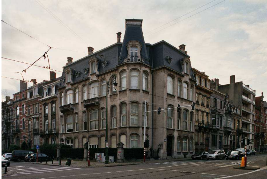
Avenue Brugmann 178, 176 – avenue Molière 177 et 179, maisons bourgeoises conçues par Paul VIZZAVONA, 1908 (photo 2006).
