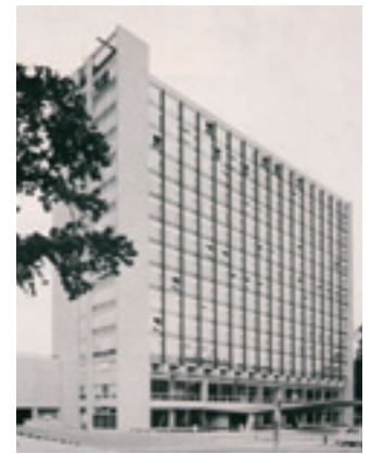
Gebouw S ( Institut de Sociologie ) in 1968, Architecture 68, 84, 1968, p. 198.
