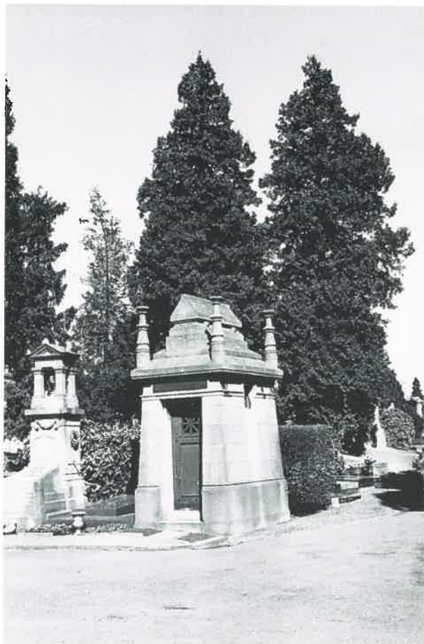
Vue sur le premier rond-point.
